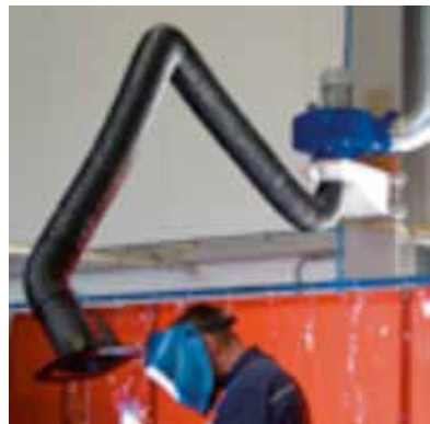
Extracción fixa para fumes de soldadura.
