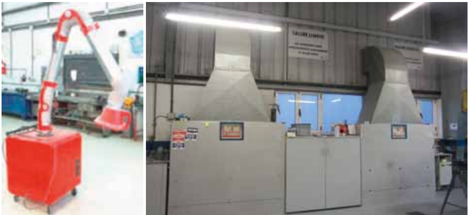
Equipo de aspiración gases procedentes das soldaduras con filtro de carbono activo.
